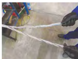
Manșonare cu manșoane din oțel conice (tip Flemish Eye) / Conical steel ferrules swaging (Flemish Eye type)
